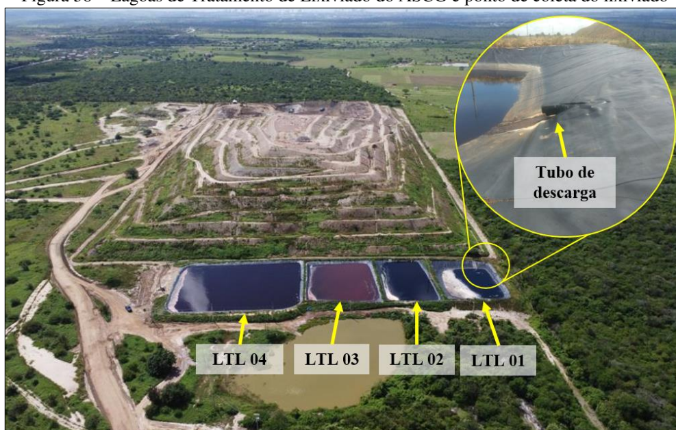
Figura 58 – Lagoas de Tratamento de Lixiviado do ASCG e ponto de coleta do lixiviado
