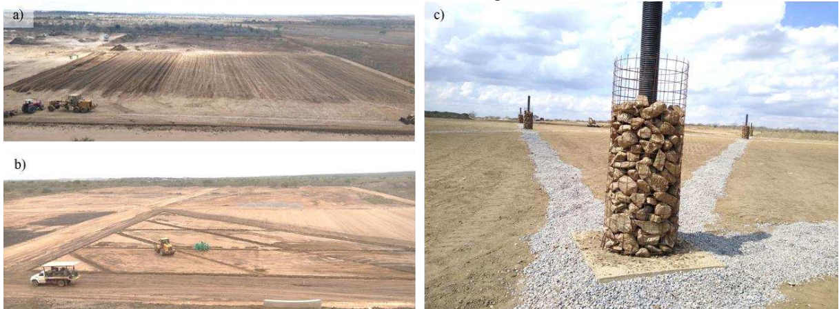
Figura 55 – Execução da camada de base do ASCG: a) compactação e nivelamento da camada; b) execução de rasgos para instalação de drenos horizontais; c) drenos horizontais (tubo PEAD envolto em britas e drenos verticais (tubo PEAD envolto em pedra rachão)
