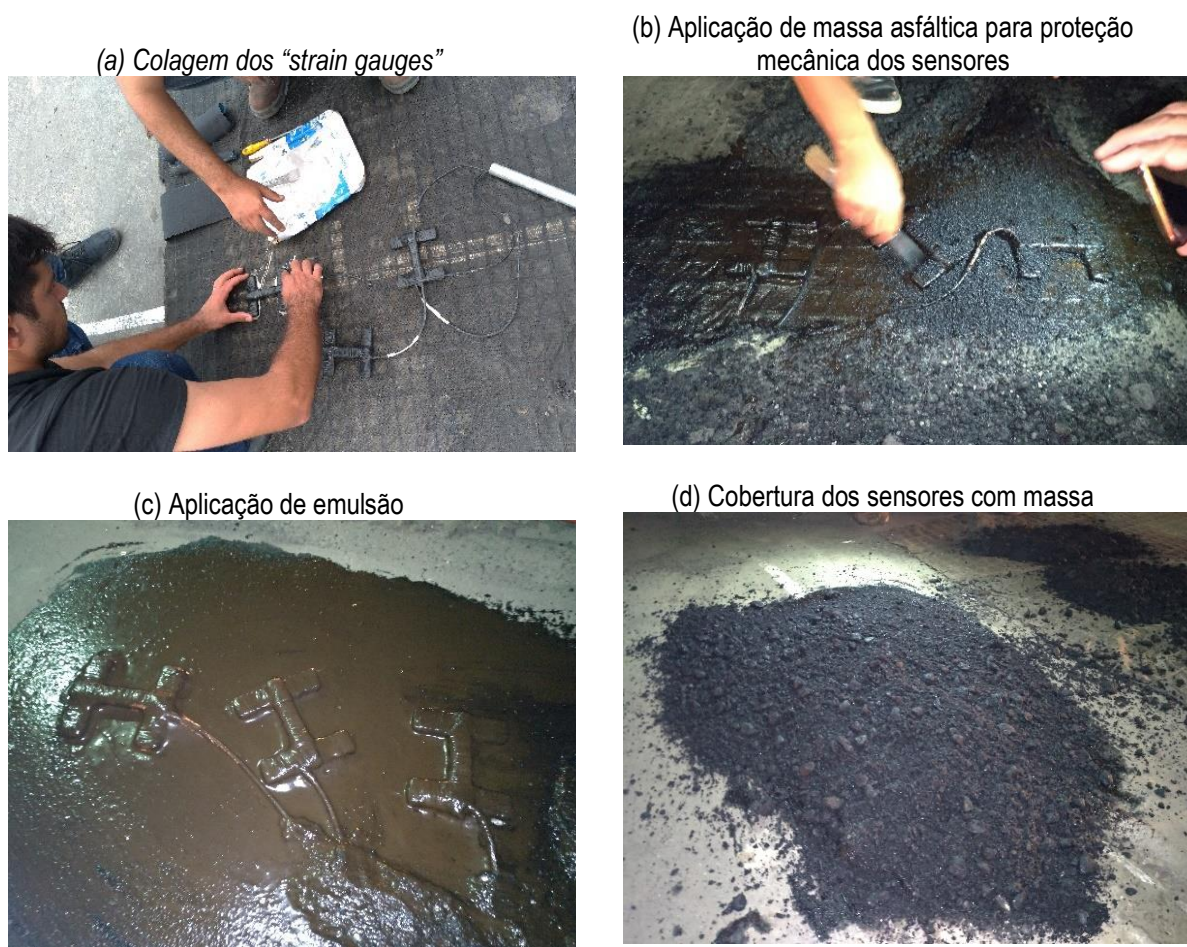
Figura 3. 23: Instalação dos sensores
