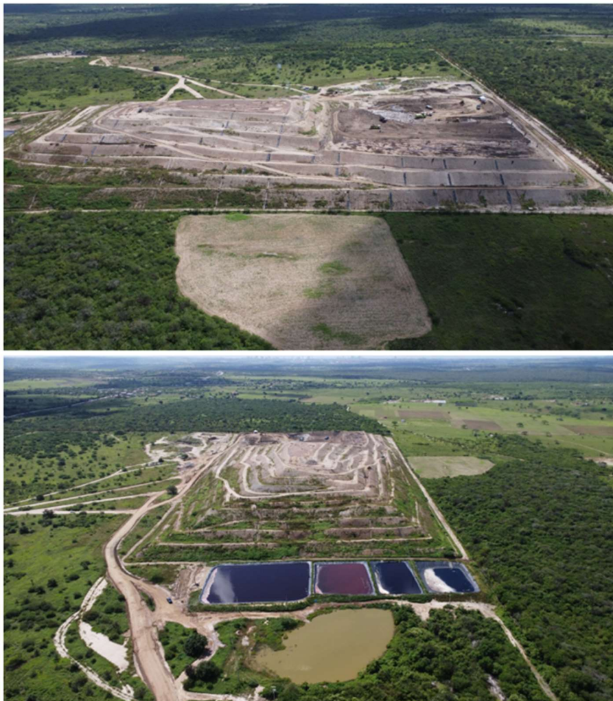
Figura 16 - Aterro Sanitário em Campina Grande (ASCG).
