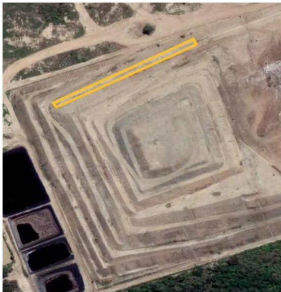
Figura 20. Descrição da área experimental na camada de cobertura.
