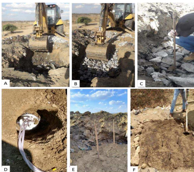
Figura 25. Etapas da instalação da Bio1 no Aterro Sanitário.
