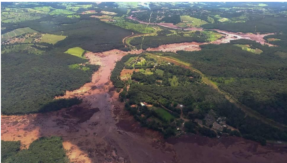
Figura 13 - Rompimento da barragem da Vale na Mina do Feijão
