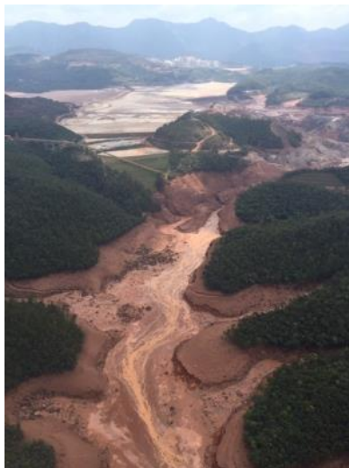
Figura 11 - Rompimento da barragem do Fundão
