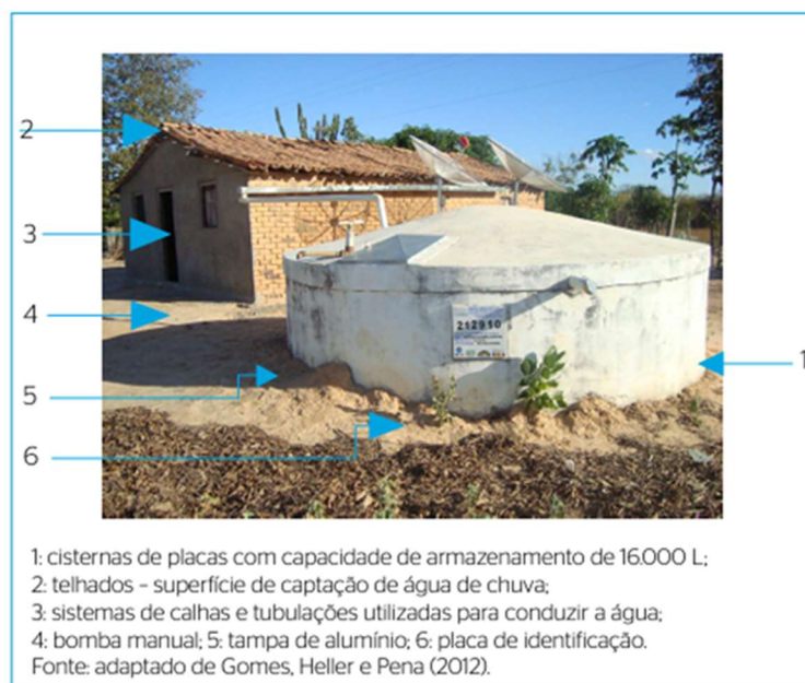
Figura 7 - Sistema de Captação de Água de Chuva do P1MC
