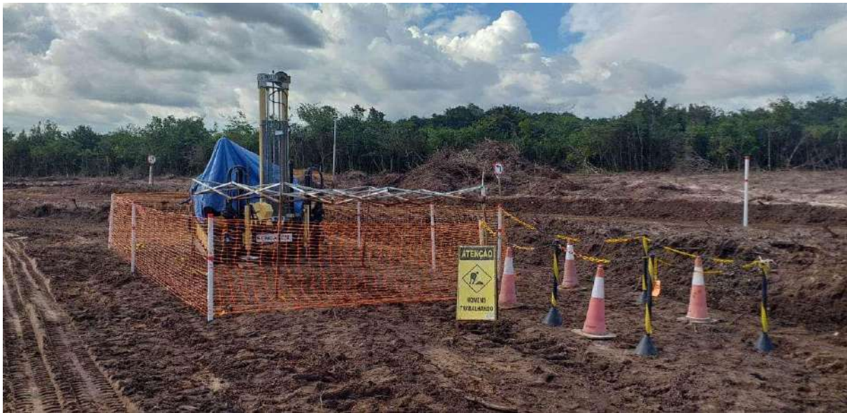
Figura 59: Execução do ensaio SCPTu 15 da ARB10. Solo (2022).
