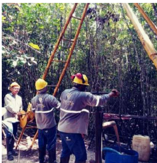
Figura 62: Execução de um ensaio SPT na ARB10.
