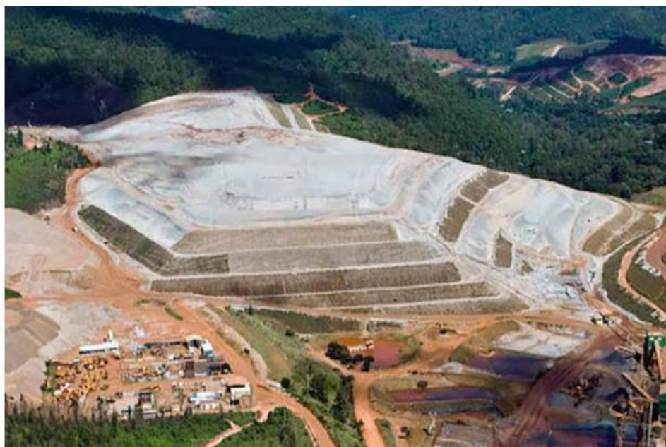
Figura 2. 10: Empilhamento drenado
