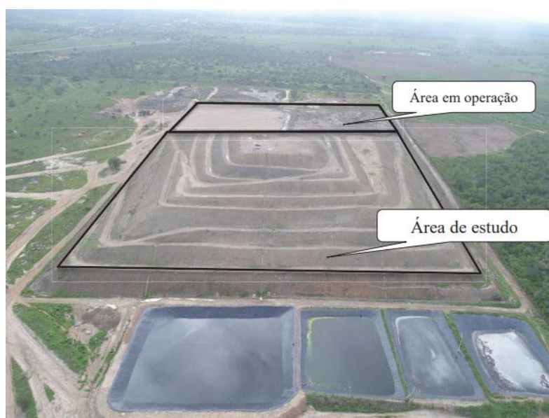
Figura 25 - Célula do aterro após junção das C1, C2, C3 e C4
