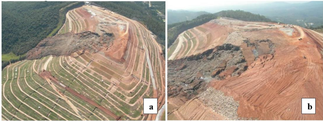
Figura 20 - Superfície de ruptura do aterro Sítio São João
