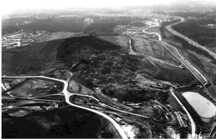
Figura 16 - Superfície de ruptura do aterro de Rumpke
