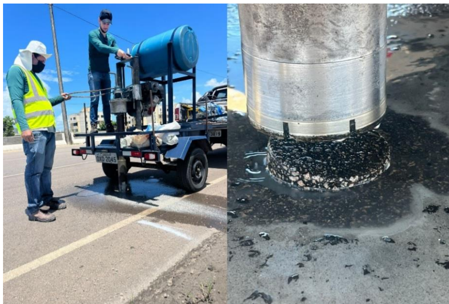
Figura 25 – Extração de amostras indeformadas do revestimento
