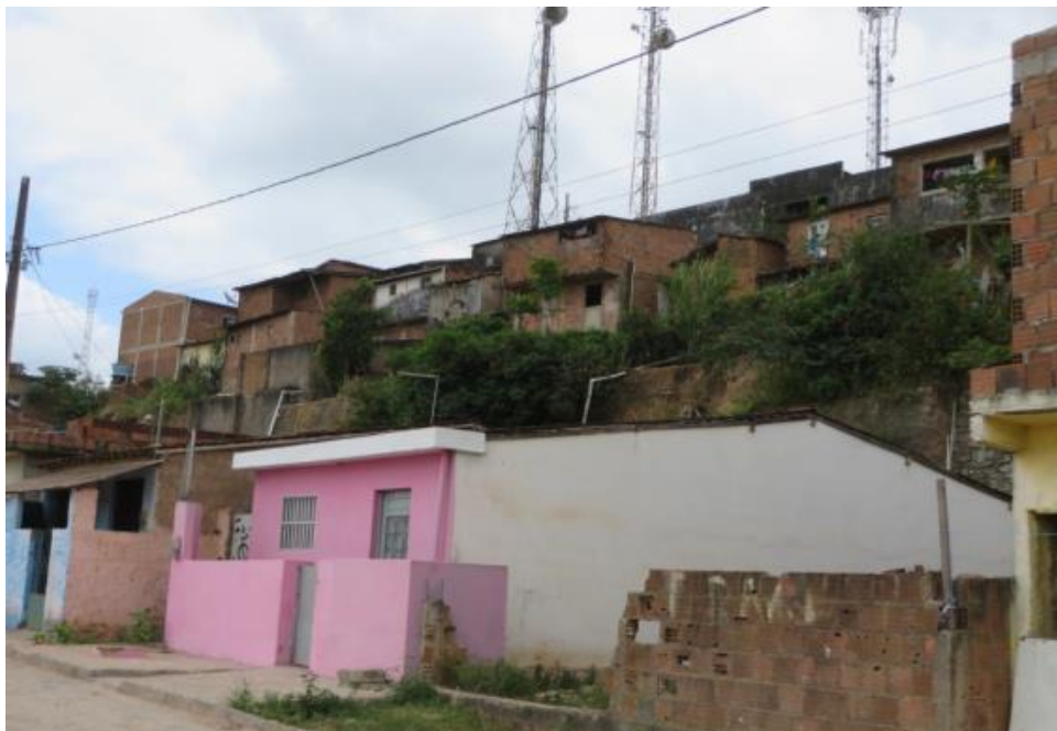
Figura 7 – Ocupação desordenada no município de Areia (PB)
