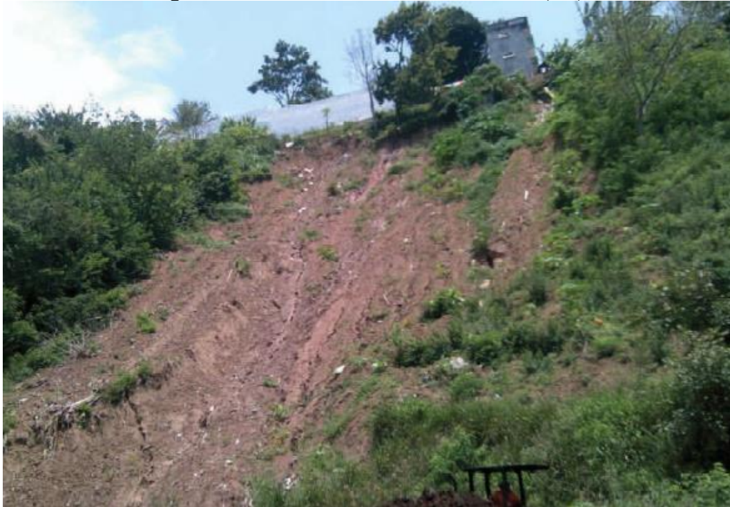
Figura 9 – Deslizamento ocorrido em Areia (PB)
