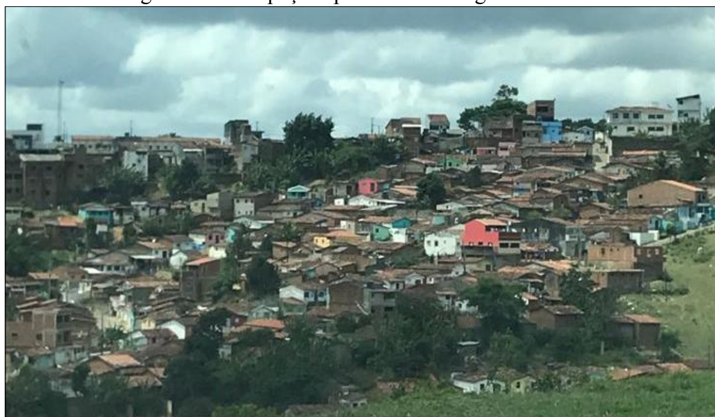
Figura 26 – Ocupações precárias ao longo de encostas
