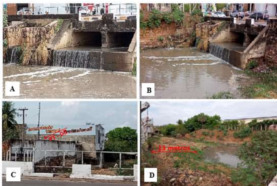
Figura 16: (A) e (B) - lançamento de esgoto no Riacho dos Macacos, (C) localização do PT-03 e (D) e distância do PT-03 ao lançamento de esgoto
