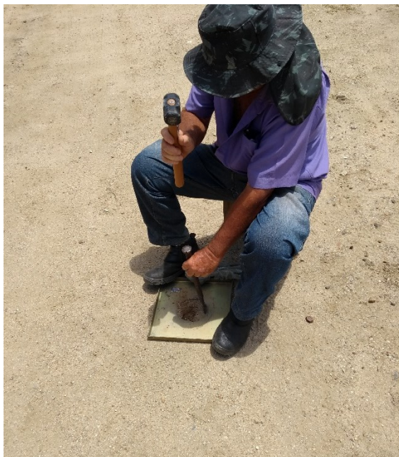
a) Abertura do furo
