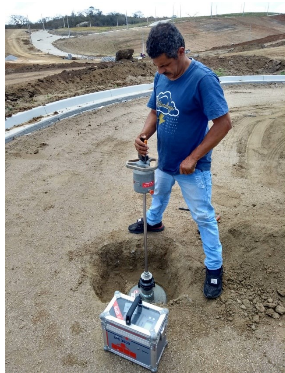
b) Ensaio em uma vala de inspeção
