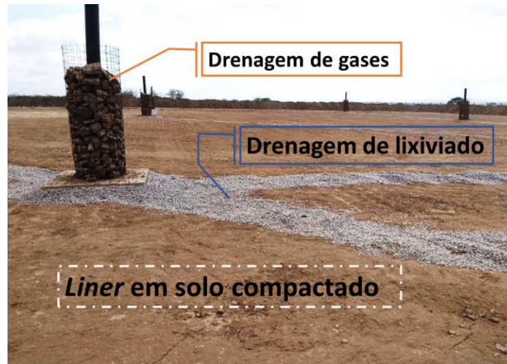
Figura 8. Sistema de impermeabilização e drenagem do ASCG
