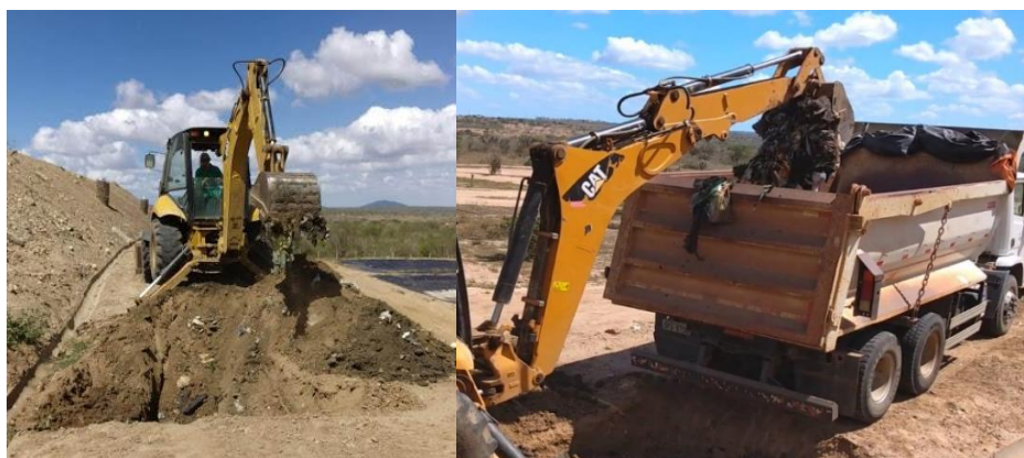
Figura 18. (a) Escavação da camada de cobertura; (b) Remoção dos RSU escavados.
