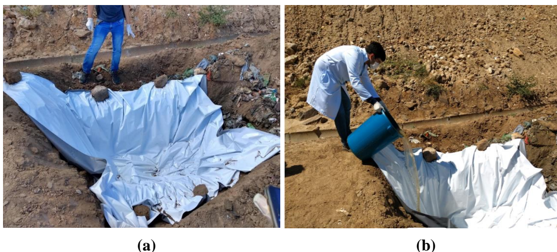
Figura 21. (a) Acomodação da lona na cava; (b) Preenchimento da cava com água.
