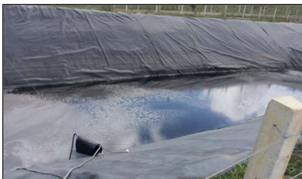
908 Figura 13 - Lagoa de Tratamento de Lixiviado do ASG
