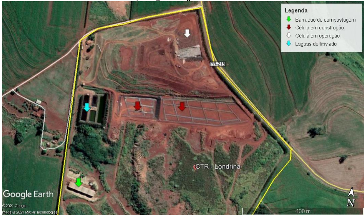
Figura 5 – CTR Londrina e indicação da célula em operação, célula em construção, barracões de compostagem e lagoas de lixiviado
