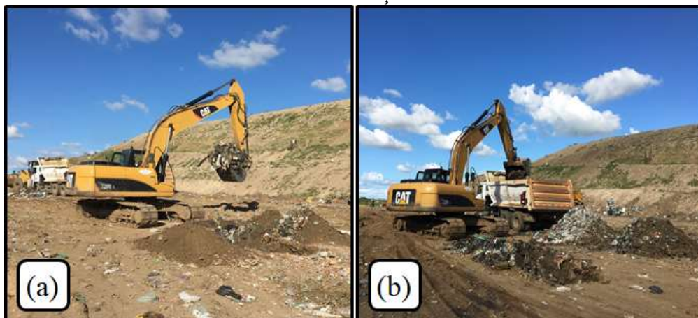
Figura 14 – (a) Coleta da amostra dos resíduos; (b) Acondicionamento dos resíduos no caminhão caçamba
