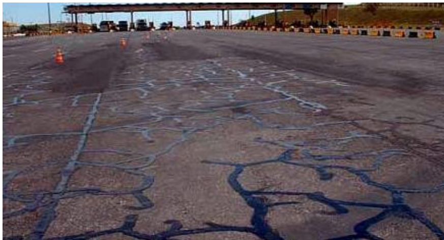
Figura 9 - Selagem de trincas em pavimento asfáltico
