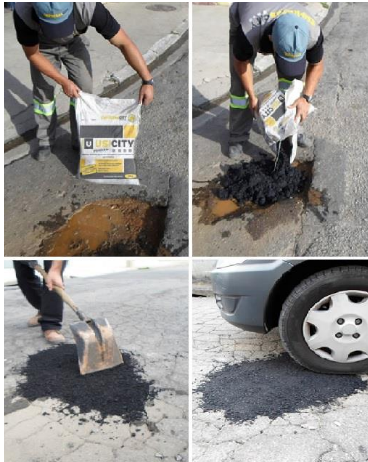
Figura 5 - Processo executivo de aplicação da MAE
