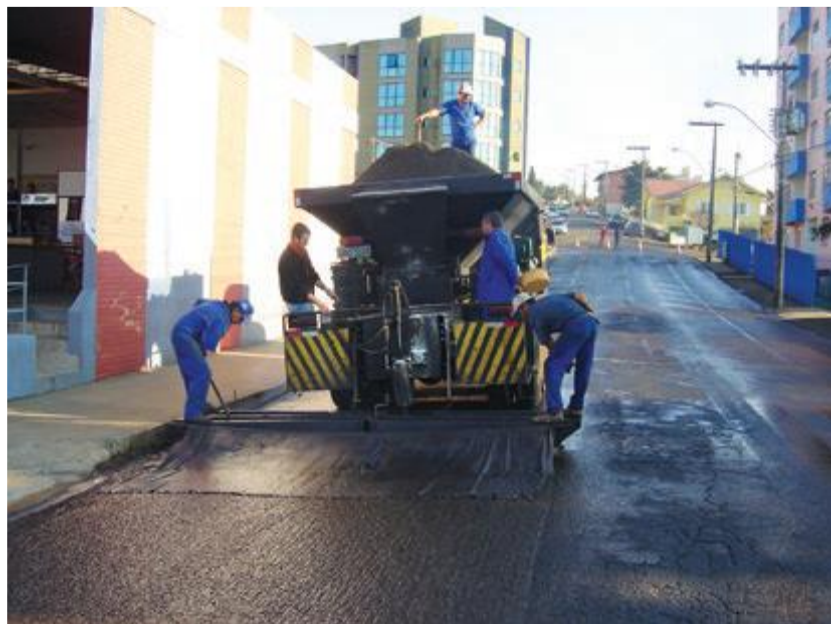
Figura 10 - Aplicação da lama asfáltica
