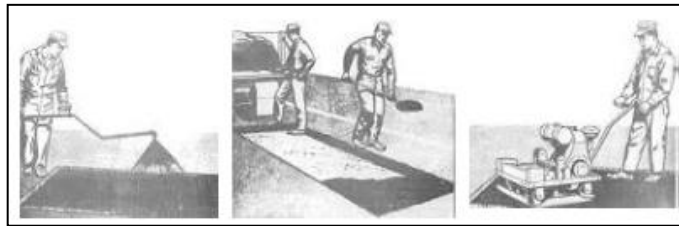
Figura 8 - sequência executiva da operação "tapa-buraco"
