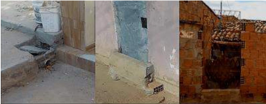
Figura 20: Barreiras instaladas nas residências para impedir entrada de água
