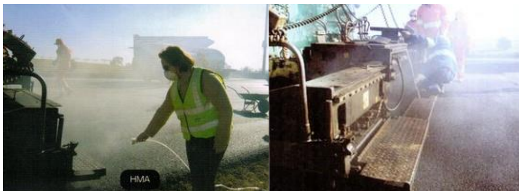
Figura 2 - Emissão de fumos na aplicação de uma mistura quente
