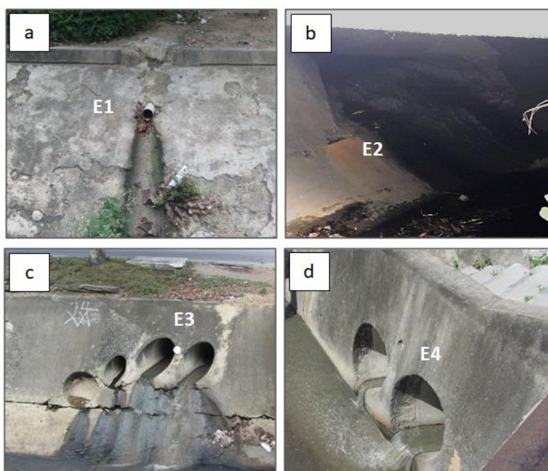
Figura 11: Imagens dos pontos de contribuição de esgoto no canal.
