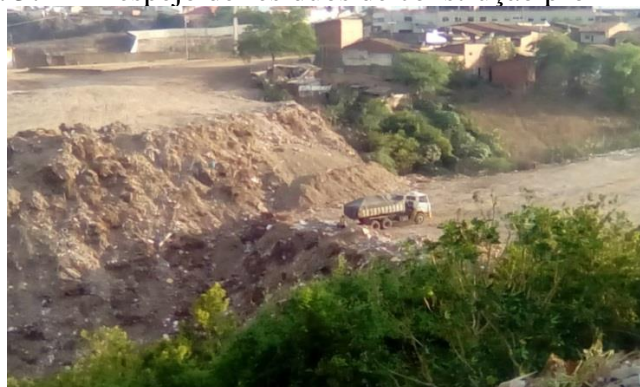
Figura 37 — Despejo de resíduos de construção próximo ao P5
