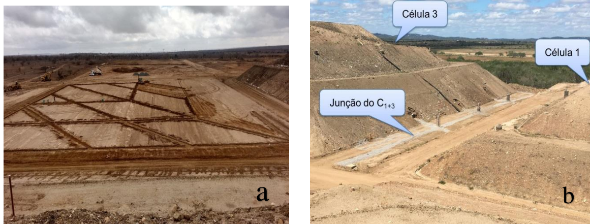
Figura 7 - Construção do sistema de drenagem de lixiviado do ASCG
