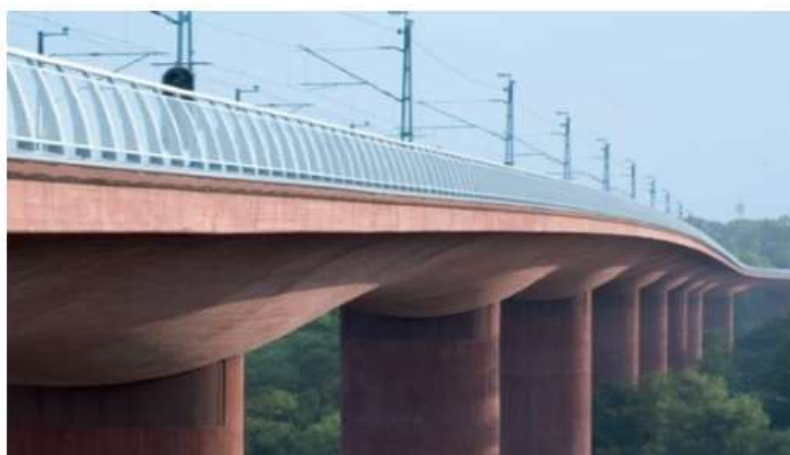
Figura 16 - Ponte em Concreto Colorido
