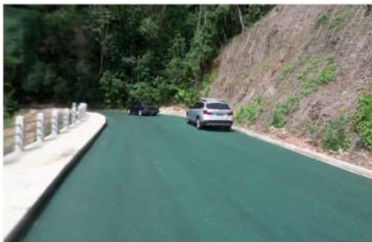
Figura 11 - Trecho da estrada Dona Castorina, Rio de Janeiro
