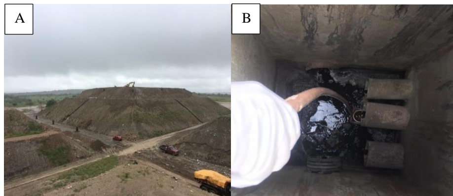
Figura 2- Aterro Sanitário em Campina Grande- PB: A) Células B) Poço de Visita
