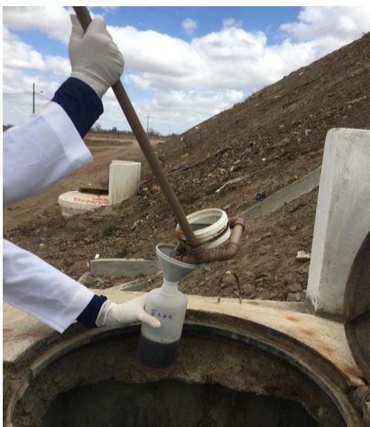
Figura 2- Poço de visita de concreto pré-moldado
