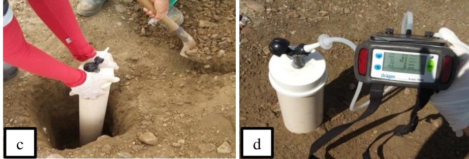
(c) instalação do Dispositivo de Medição de Concentração de gases (DMC)
