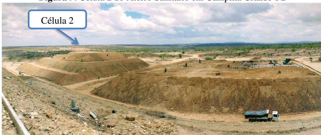
Figura 9. Célula 2 do Aterro Sanitário em Campina Grande-PB
