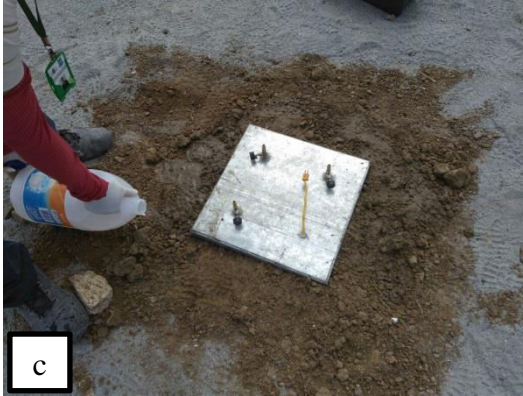
(c) aplicação de mistura de solo e bentonita para criação de selo hidráulico
