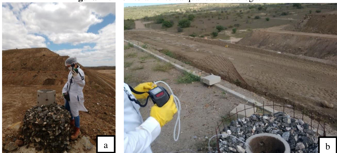
(a) medições diretas nos drenos verticais
