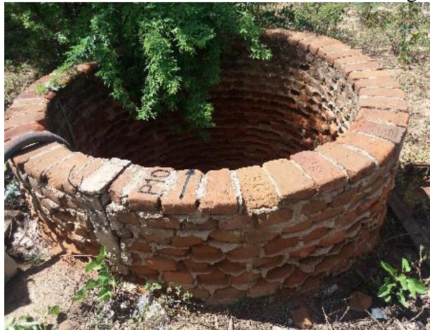
Figura 7: Poço em que é realizado o monitoramento do nível estático com marcação do local onde deve ser realizada a leitura do nível da água
