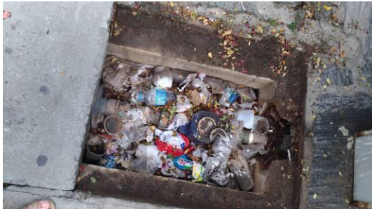
Hidrômetro da CIAC (e)
