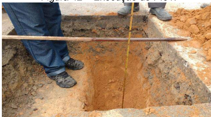
Figura 42 – Execução do PI01.
