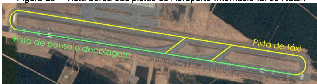
Figura 23 – Vista aérea das pistas do Aeroporto Internacional de Natal.
