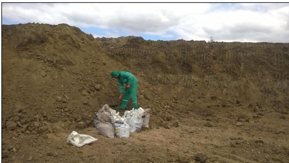
Figura 25 - Coleta do solo para ensaios de caracterização.
