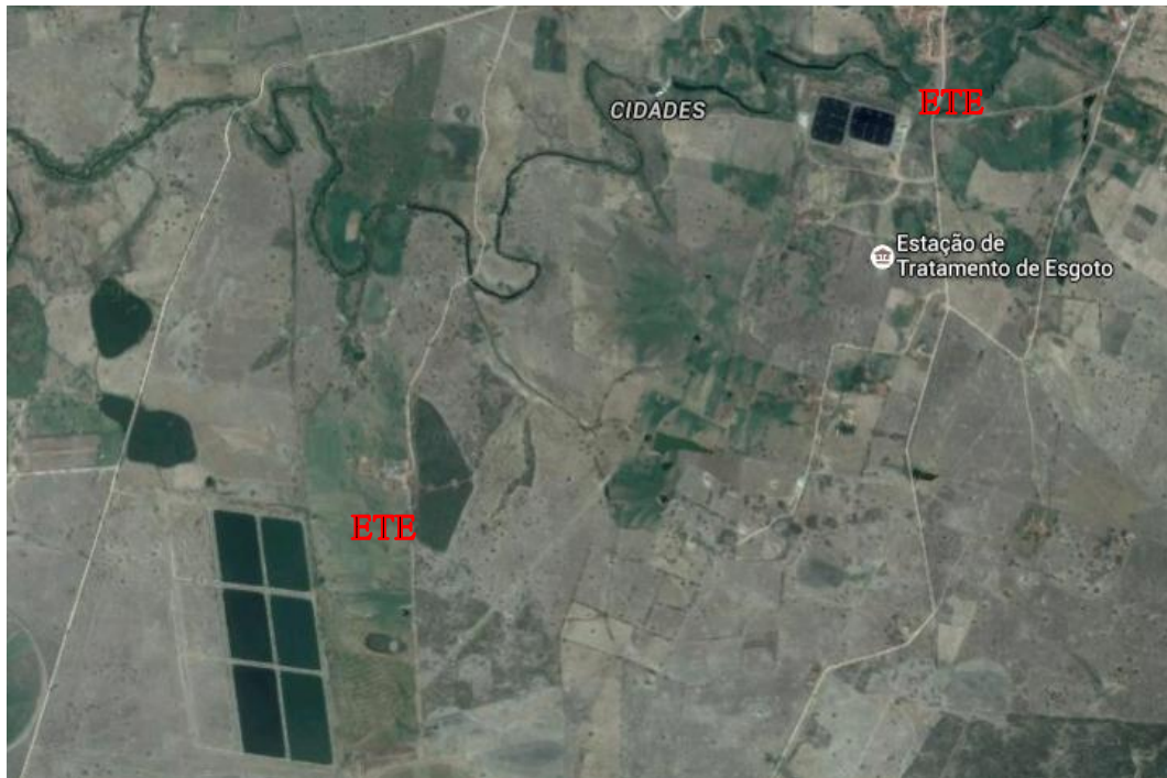
Figura 11 - Estação de Tratamento de Esgoto de Campina Grande.
