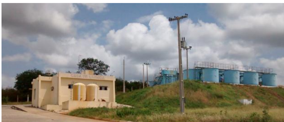
Figura 10 - Estação de Tratamento de Água de Itatuba.
