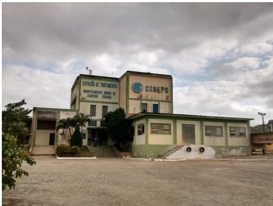
Figura 9 - Estação de Tratamento de Água de Gravatá de Queimadas.
