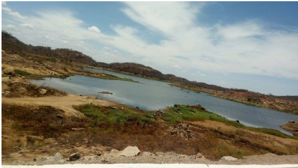
Figura 3 - Vista Parcial do Açude de Camalaú. Fonte: Autor, (2016).
