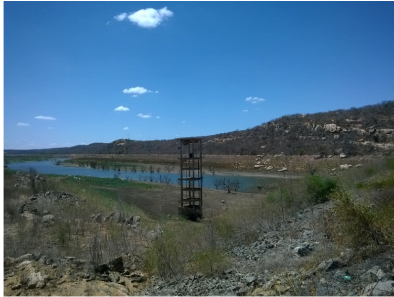
Figura 4 - Vista parcial do açude Cordeiro. Fonte: Autor, (2016).
