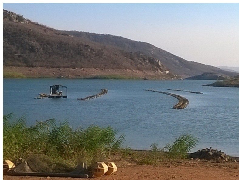
Figura 5 - Vista Parcial da Barragem de Acauã (2016). Fonte: autor (2016).
