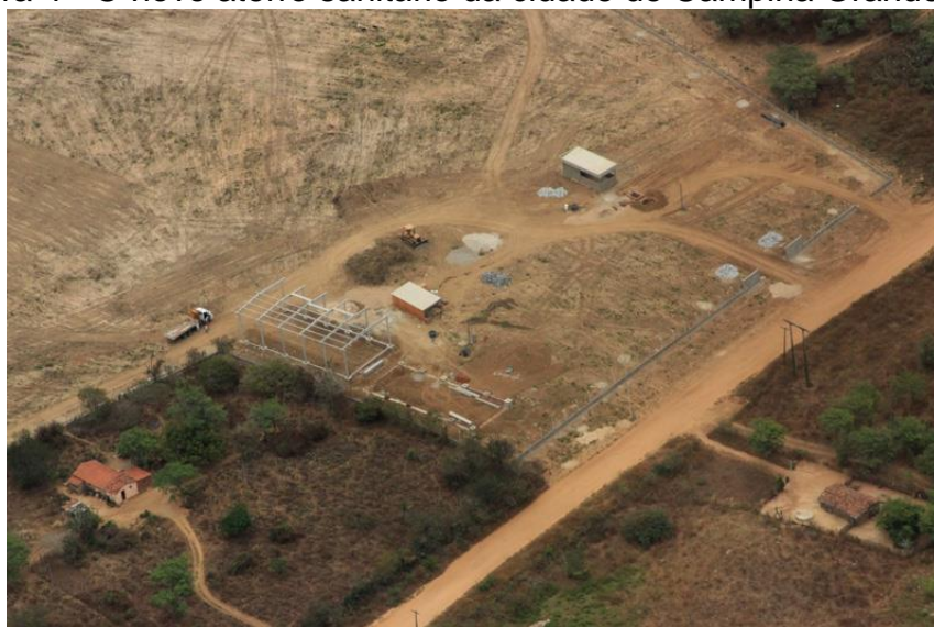
Figura 4 - O novo aterro sanitário da cidade de Campina Grande - PB
