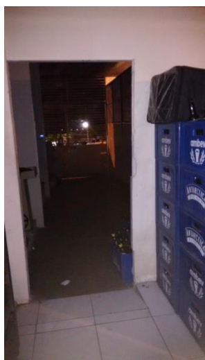
Figura 16: Fotos da vistoria da edificação A.
