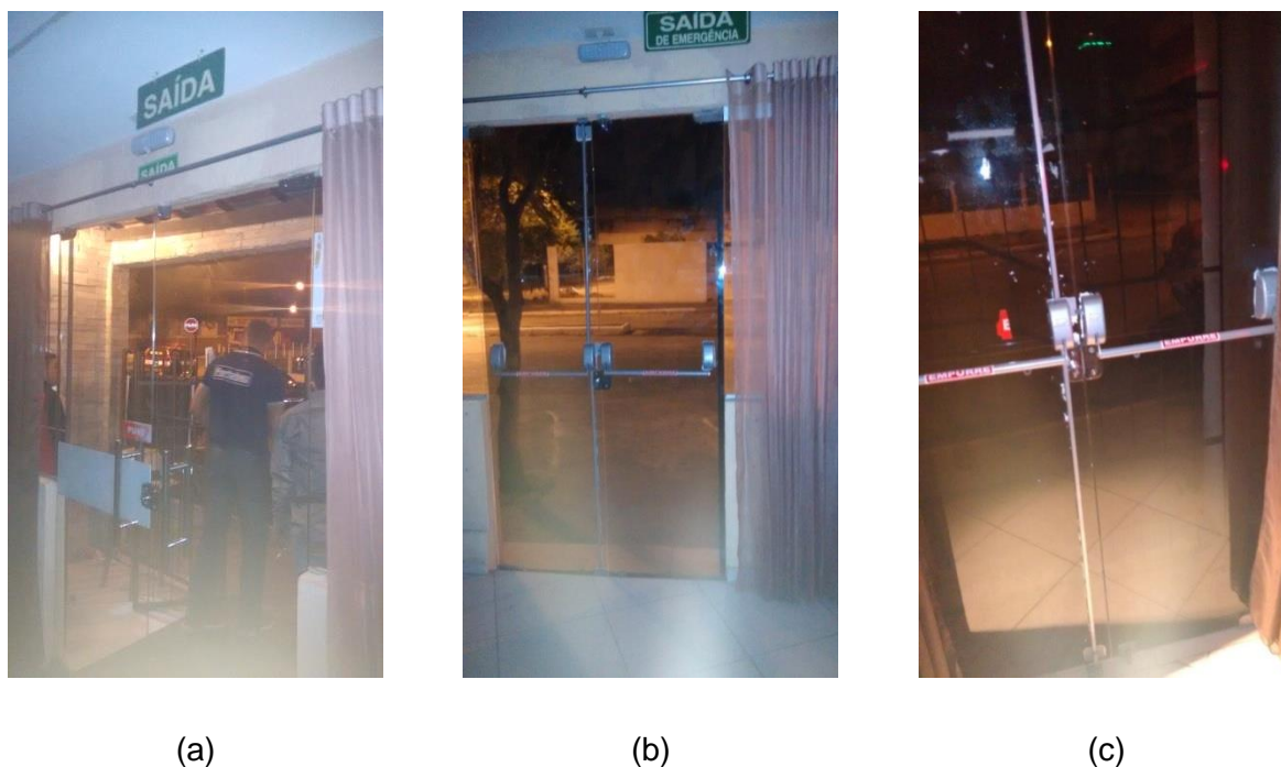
Figura 23: Portas da edificação B.
