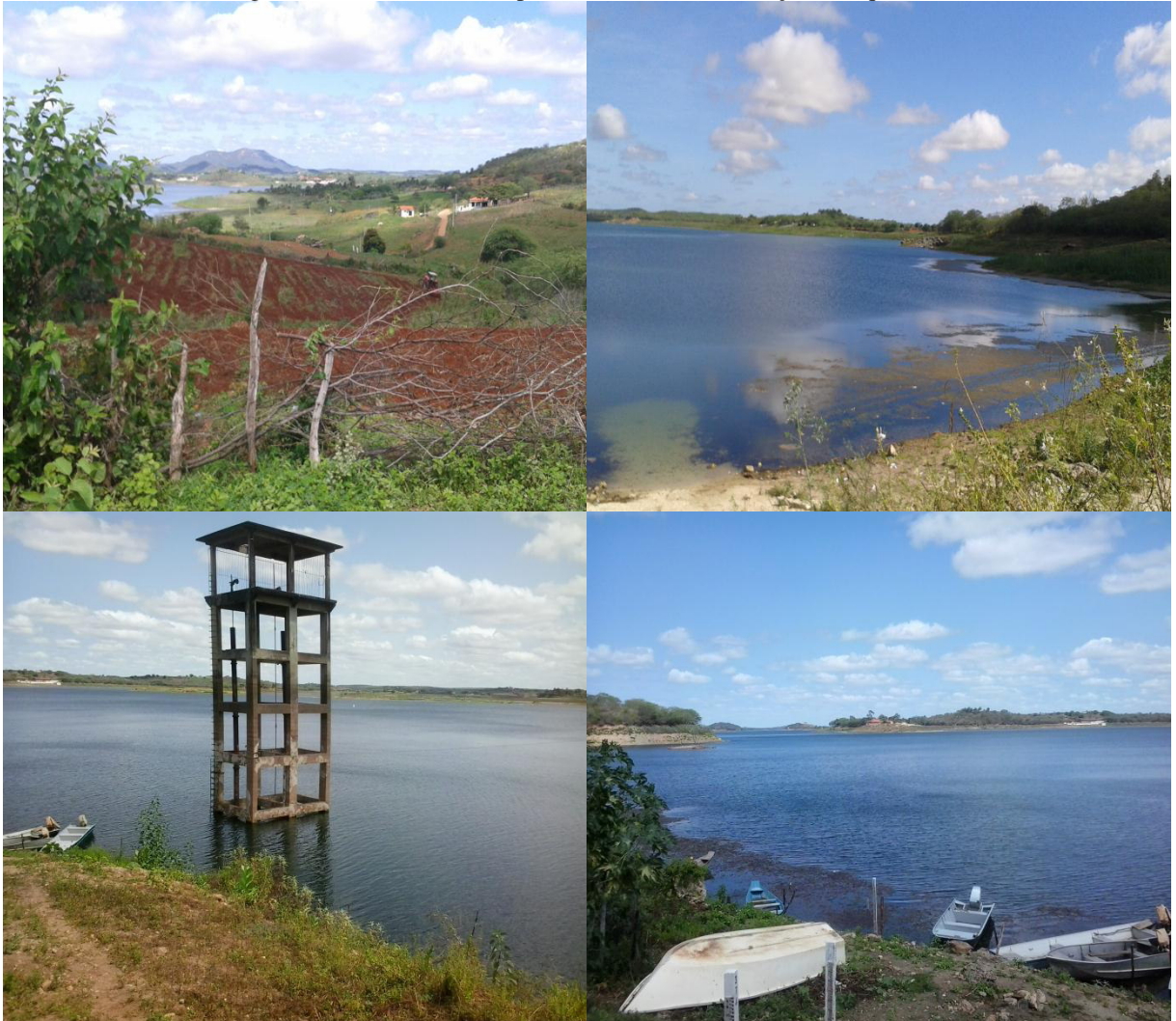
Figura 12 – Visitas de acompanhamento in loco no Açude Boqueirão.
