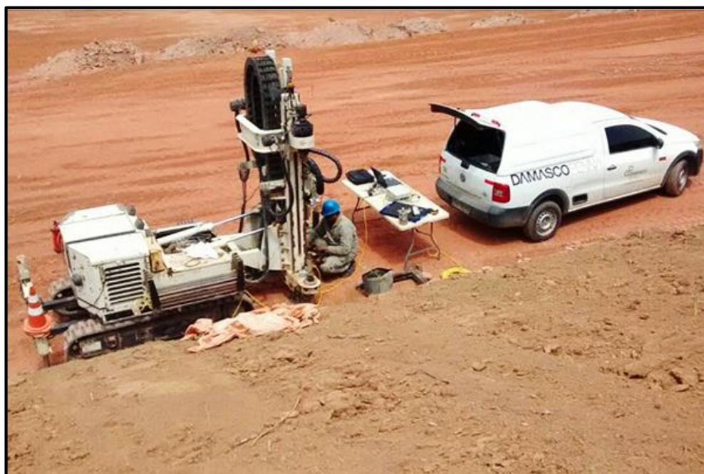
Figura 10: Equipamento CPT em funcionamento
