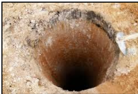
Figura 3: Poço de inspeção
