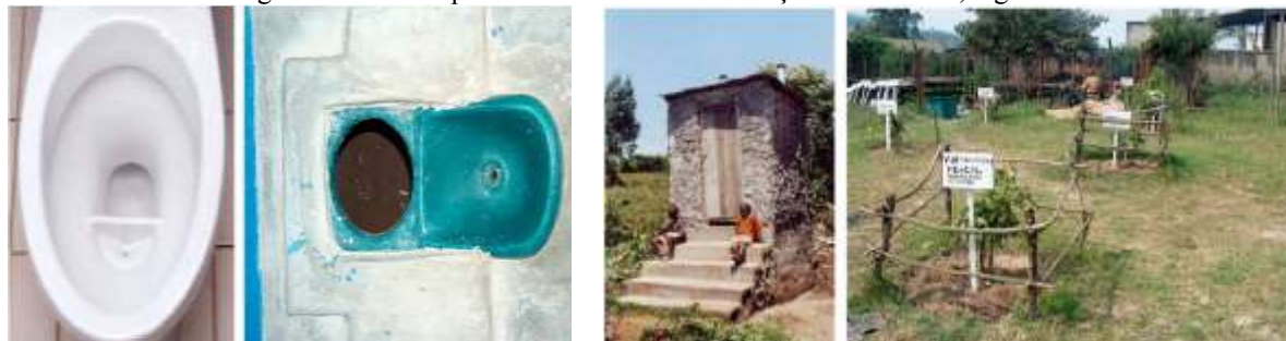
Figura 4 – Vaso separador de excretas e utilização em Kisoro, Uganda.
