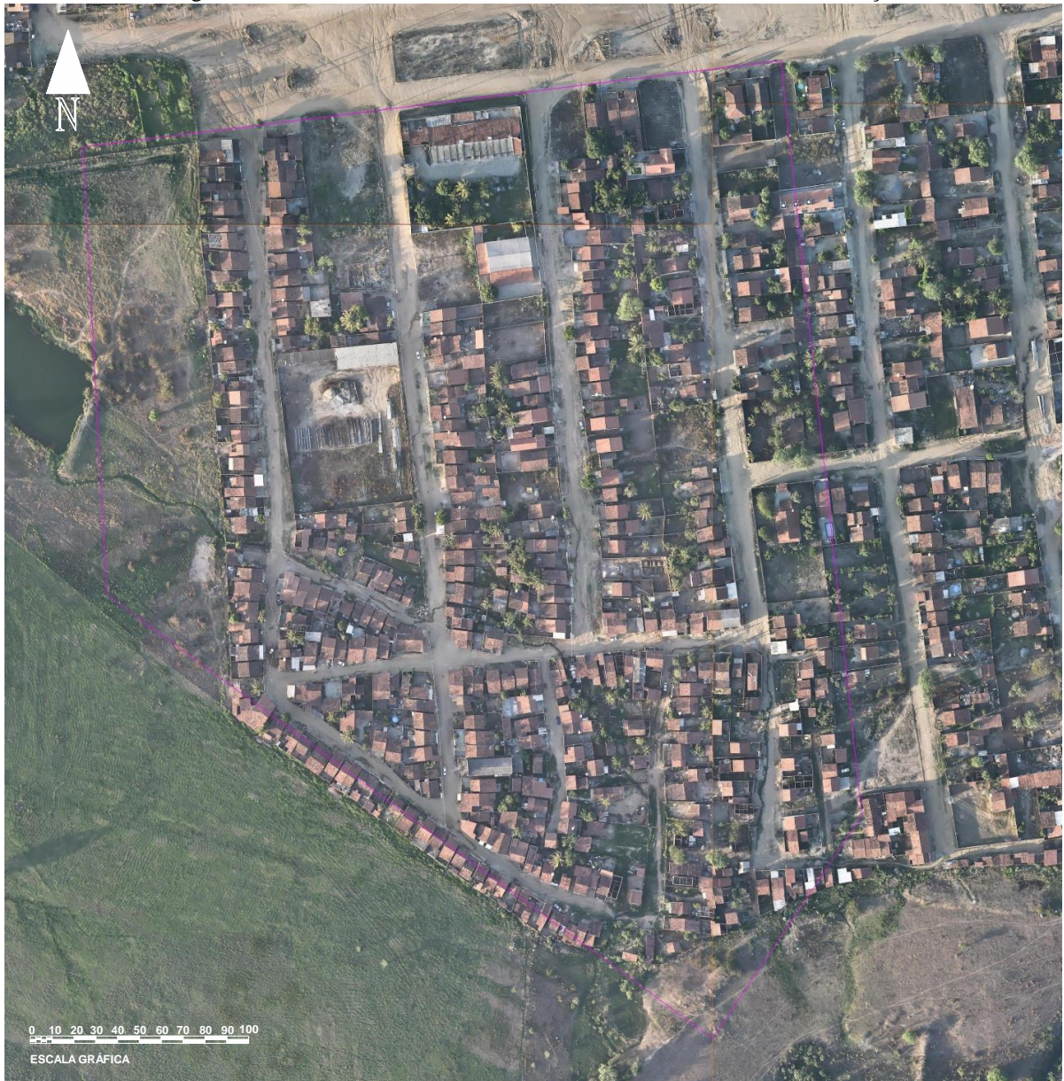
Figura 10 - Vista aérea da Comunidade Novo Horizonte antes da urbanização
