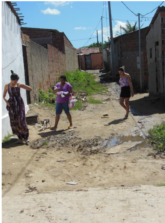
Figura 37 - Rua não pavimentada na poligonal urbanizada
