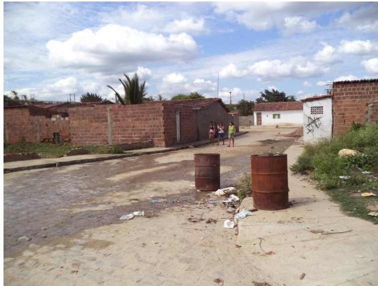
Figura 34 - Acúmulo de resíduos nas calçadas e sarjetas
