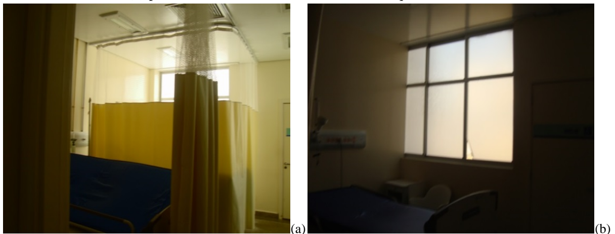
Figura 4.13 – Intervenientes detectados nas enfermarias: (a) anteparos que dificultam a iluminação no leito e (b) película branca no leito 05 da enfermaria queimados.
