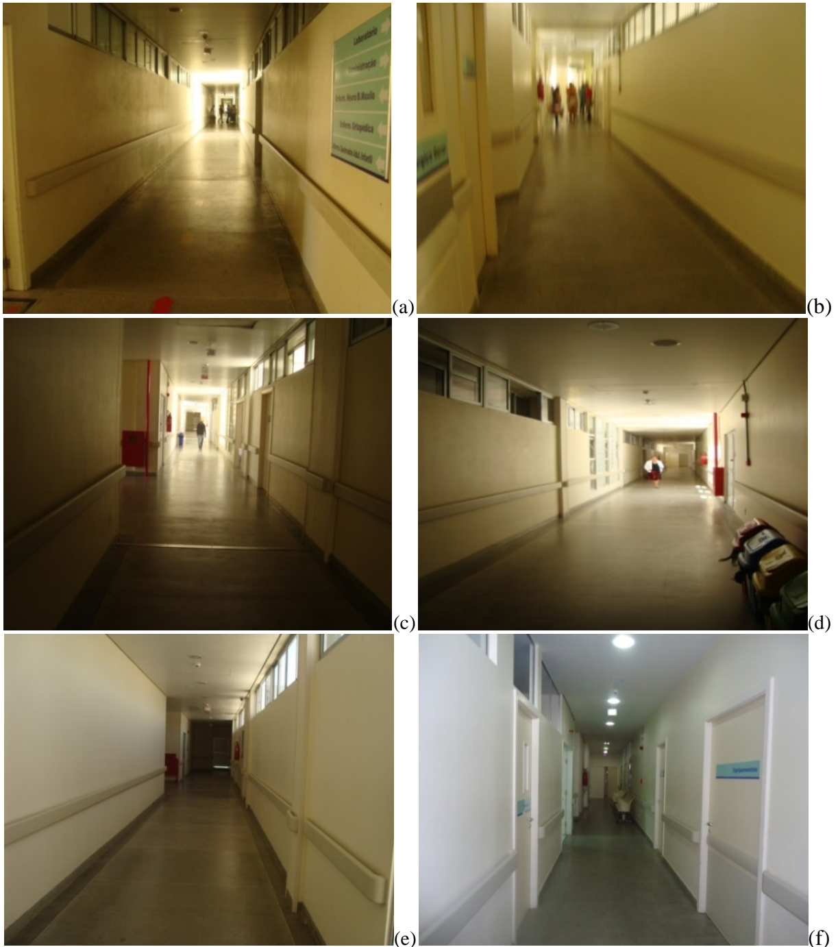
Figura 4.9 –Locais de aferição das iluminâncias nos corredores centrais de acesso as enfermarias: corredor central do pavimento térreo (a), P7-1 (b), P9-1 (c), perspectiva da fotografia do final do corredor central do primeiro pavimento em direção ao início (d), P15-1 (e) e corredor central do pavimento térreo durante o período noturno (f).
