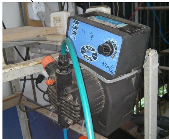
Figura 3.3: Bomba dosadora para alimentação do sistema UCT.
