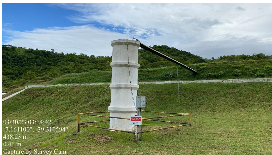
Figura 17 – Poço de visita (PV) do Aterro sanitário de Juazeiro do Norte
