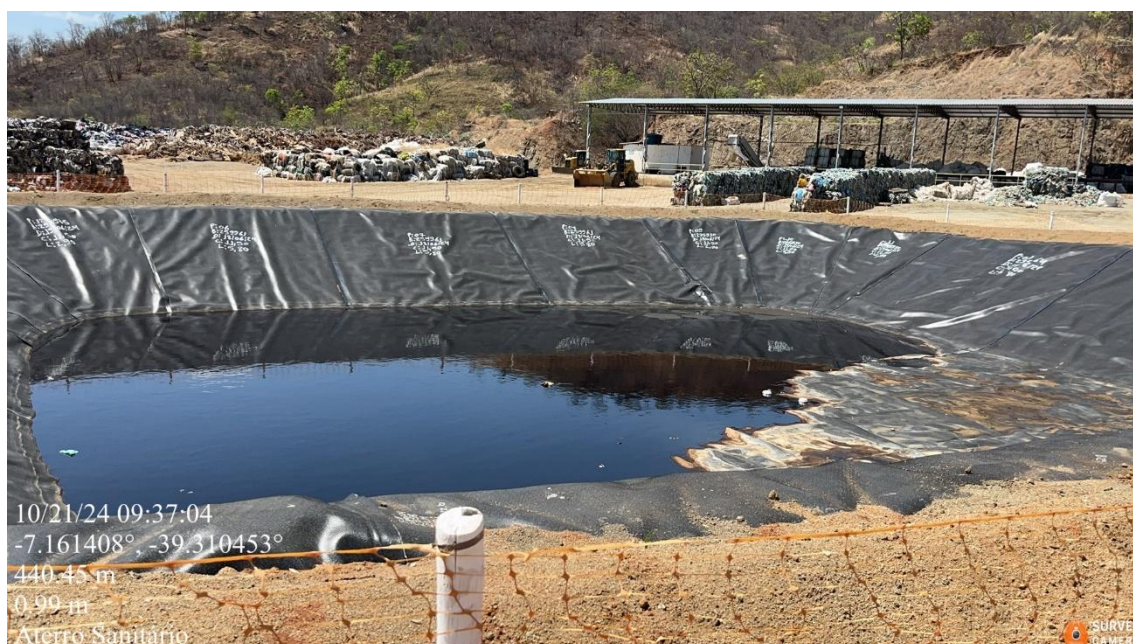
Figura 16 – Lagoa de acumulação de lixiviado do Aterro sanitário de Juazeiro do Norte
