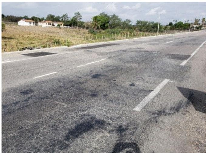
**Figura 72** - Defeitos observados na rodovia BR-230/PB – Painelas e trincas interligadas
