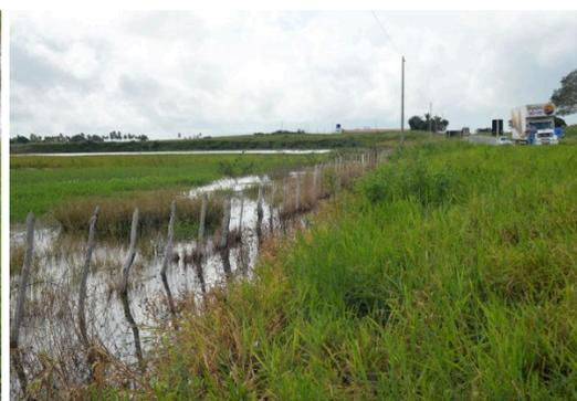
Além destes aspectos, o açude localizado à margem da rodovia, no período de inverno, espraia água para saia do aterro provocando com a isso a percolação da água por capilaridade para as camadas do pavimento. Este efeito acaba por resultar em elevadas deflexões nesse segmento ocasionando a degradação do pavimento. Esse aspecto será discutido no item de avaliação estrutural.
