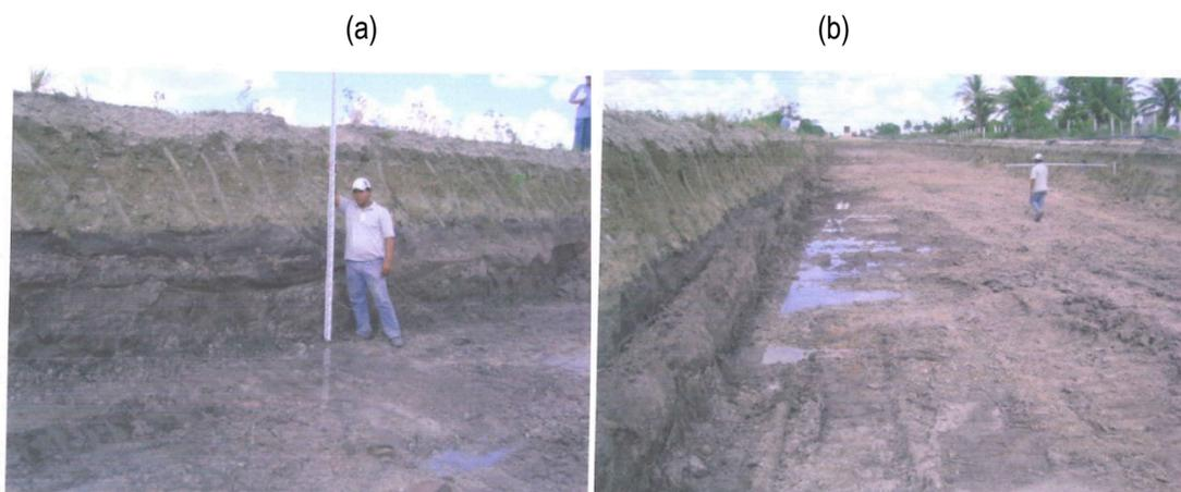
**Figura 35** -Implantação do colchão de areia (a) e do dreno transversal tipo PEAD (b)
