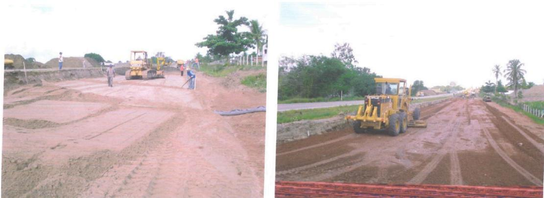
A execução do colchão de areia e sobre este a camada de argila (selo) não se mostrou eficiente no sentido de restaurar as condições funcionais e estruturais do segmento tendo em vista que o pavimento continuou a se degradar.
